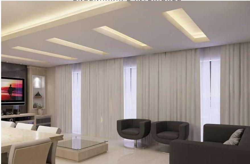
Figura 6: ex. de rasgo de gesso iluminado com led referência 5050 cor neutra
