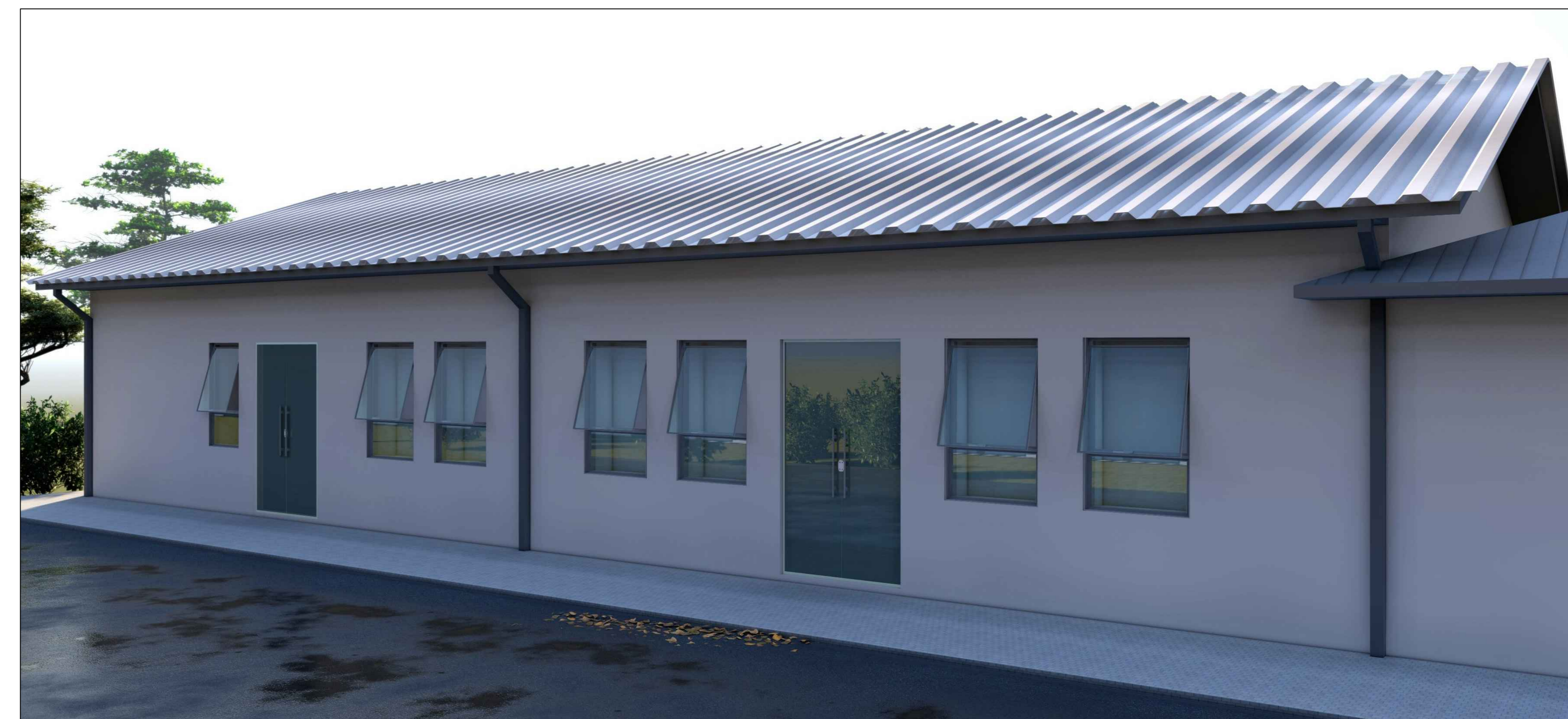
Vista lateral perspectiva 3D Cobertura telha sanduiche
